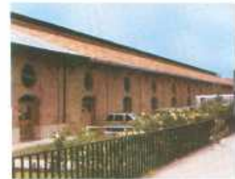
La Comisión Nacional de Emergencia estuvo ubicada por aproximadamente tres años en el antiguo edificio de la Adtava.
