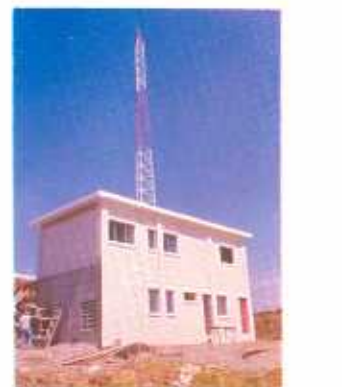
Edificio de Comunicaciones de la C. N. E.
