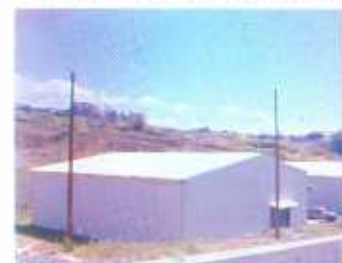
Bodegas de la C.N.E., las cuales se utilizan para el almacenamiento de material para casos de emergencia y para la flota de vehículos.
