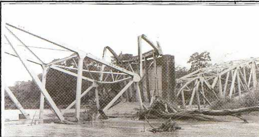
Debido a los daños en puentes y carreteras la población limonense se mantuvo incomunicada por varias horas; entre tanto se les brindó asistencia por vía aérea.
