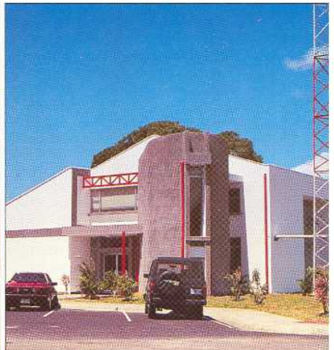
Edificio de la Central Única de Alarmas 9-1-1 en las instalaciones de la Comisión Nacional de Emergencia, Púrcos
