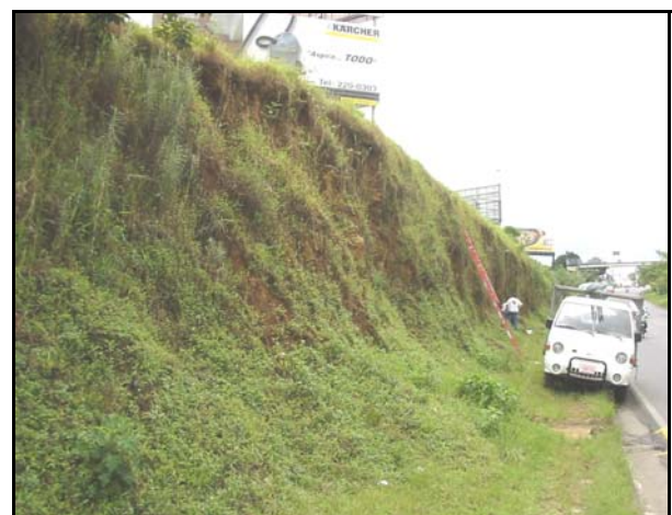
Figura 2.1.6: La unidad de cenizas entre la rotonda de la Bandera y el cementerio de Guadalupe, el espesor máximo visible es de 7 metros.
