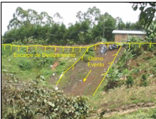
Figura 3.5: Escarpe de deslizamiento, Liburgia.
