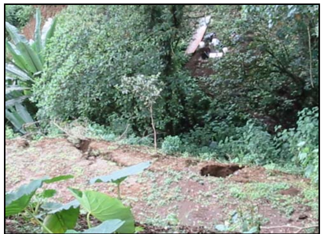
Figura 4.2: Laderas de cañones fluviales agrietadas, propensas a deslizamiento y afectadas por acción antrópica. Cerca de finca Terrazas.
