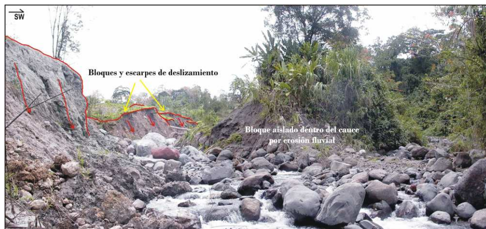
FIGURA 3.44. VISTA HACIA AGUAS ARRIBA EN EL RÍO CALVARIO. A LA IZQUIERDA SE OBSERVAN LOS BLOQUES DE DESLIZAMIENTOS CON MOVIMIENTO SUROESTE LOS CUALES SON EROSIONADOS EN SU BASE POR EL RÍO CALVARIO.
