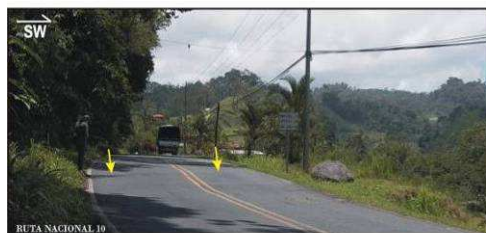
FIGURA 5.19. GRIETAS GENERADAS POR DESLIZAMIENTO GENERAN DAÑOS EN LA RUTA NO.10, EN LA PLAZA NUEVA Y EN EL CEMENTERIO DE TRES EQUIS.
