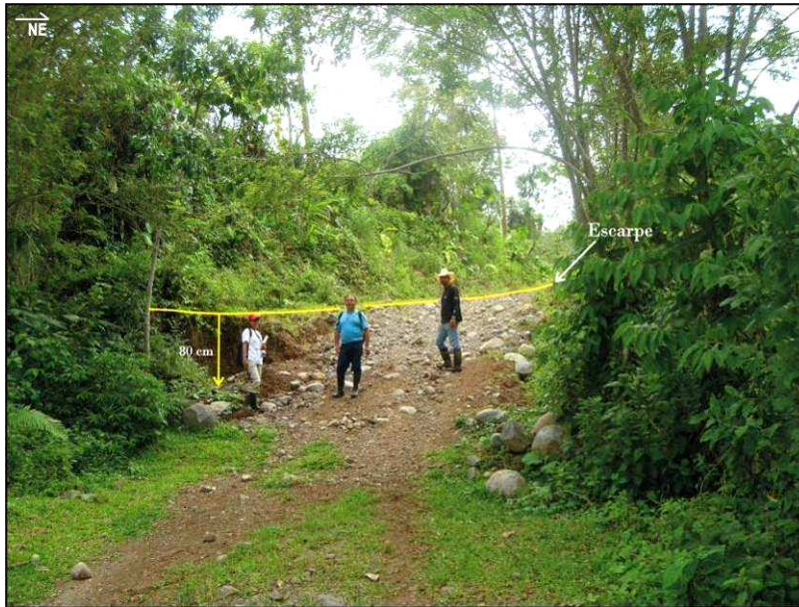
FIGURA 3.59. GRIETA EN EL ESCARPE FINCA BLAKE CON DESPLAZAMIENTO VERTICAL DE 80 CM Y RUMBO N40W, SEPTIEMBRE, 2011. COORDENADAS: 214074 N / 583881 E
