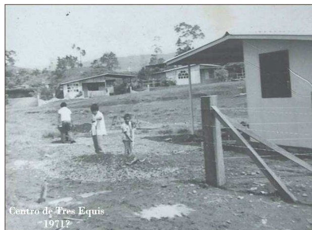
FIGURA 5.6. INICIOS DEL POBLADO DE TRES EQUIS ENTRE LOS AÑOS 1971-1972, CONSTRUCCIONES REALIZADAS CON MÓDULOS PREFABRICADOS EN MADERA.
