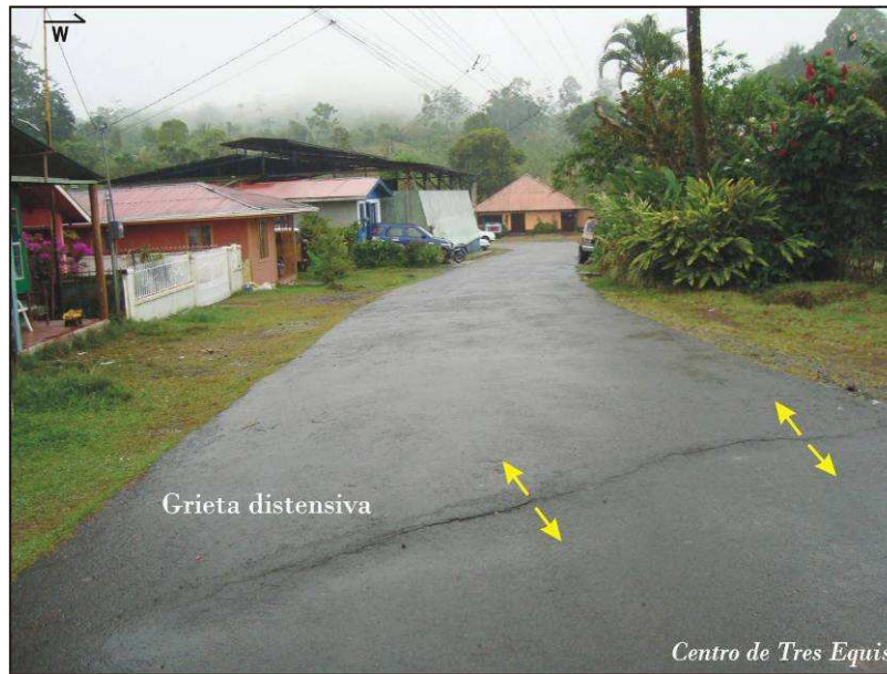
FIGURA 5.14. DAÑOS EN CARRETERAS POR GRIETAS DE DESLIZAMIENTO, SECTOR ENTRE LA ESCUELA Y LA FUERZA PÚBLICA DE TRES EQUIS. LAS GRIETAS DE DISTENSIÓN PRESENTAN UN RUMBO N58E. COORDENADAS: 216226N-583322E.
