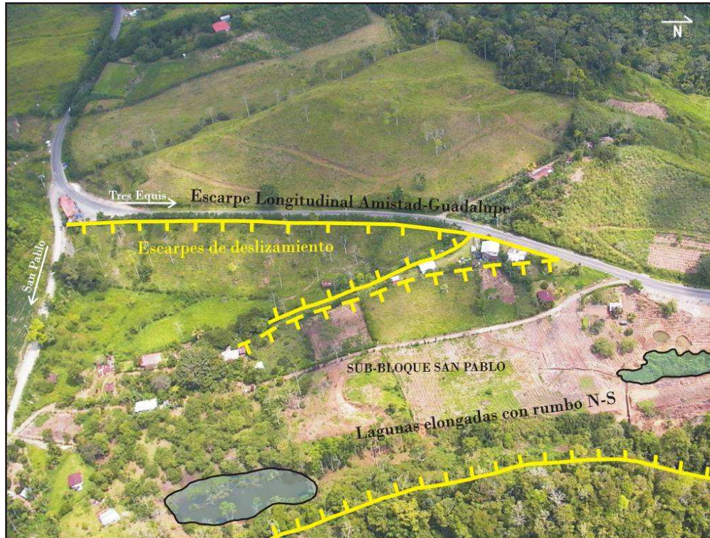
FIGURA 3.53. VISTA EN PLANTA DEL ESCARPE LONGITUDINAL, INTERSECCIÓN ENTRE LAS RUTAS 10 Y 413 (TRES EQUIS – SAN PABLO). COORDENADAS: 214803 N / 583333 E
