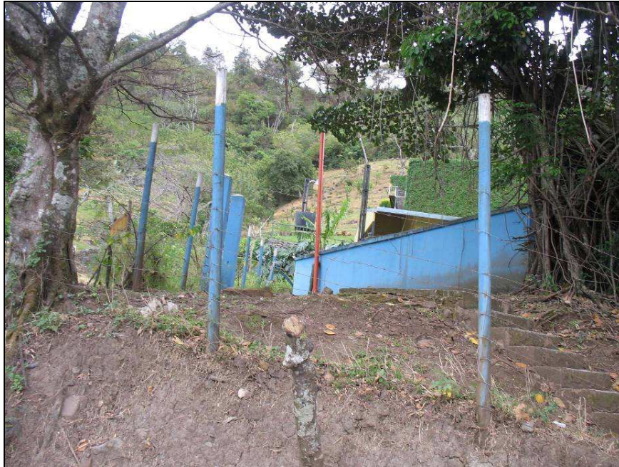
Fotografía N° 10.3: Tanque del Sistema de Acueductos del AyA, ubicado a un costado de la Ruta 311 y en los alrededores de la confluencia de la Quebrada Tapezco con el Río Uruca. (26 Enero, 2012).
