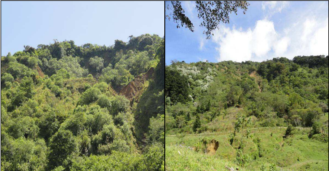
Fotografía Nº 2.10 Y 2.11: Se puede observar en la imagen de la izquierda un acercamiento del área superior del deslizamiento, mientras que en la imagen de la derecha se puede observar una vista panorámica de la misma zona. Se puede apreciar que dicho espacio presenta una revegetación importante.
