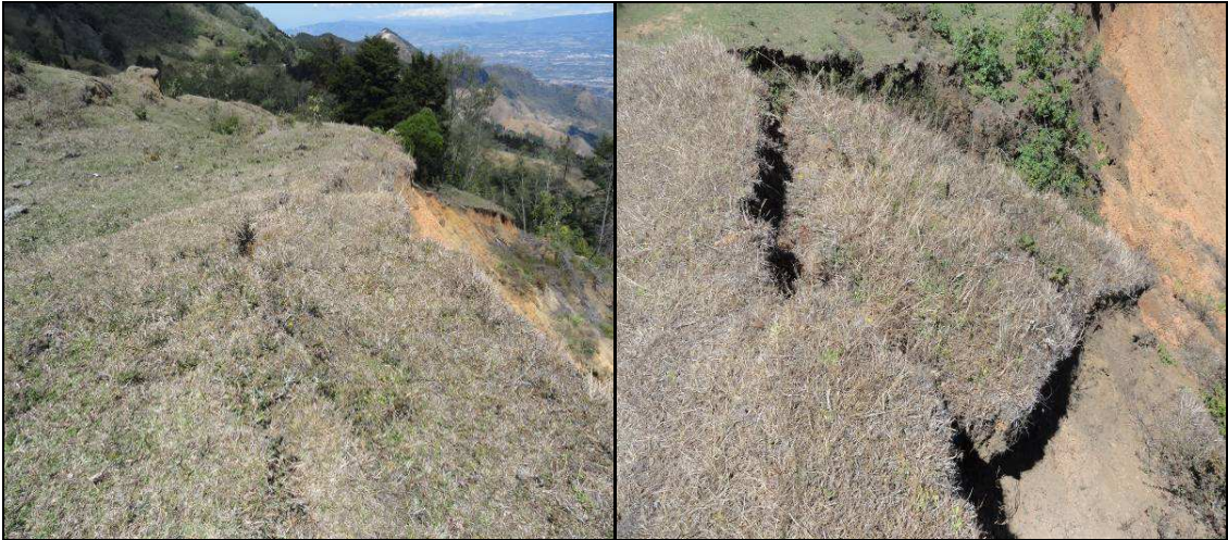
Fotografía Nº 6.6 y 6.7: En ambas imágenes se pueden apreciar parte de las grietas existentes
