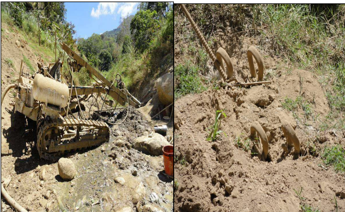
Fotografía N° 6.10 y 6.11: Se puede apreciar maquinaria trabajando en la colocación de la barrera contra flujos de detritos. Así mismo se puede observar los anclajes que soportan la malla
