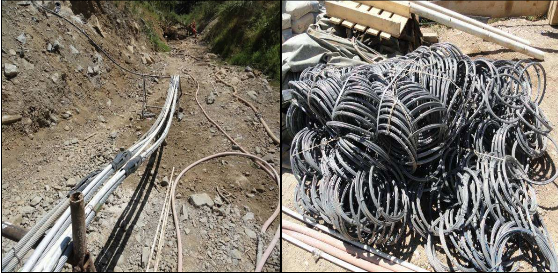
Fotografía N° 6.8 y 6.9: En la imagen de la izquierda se puede apreciar los cables que sujetan la malla retenedora. A la derecha se observa la malla o barrera retenedora que se colocará
