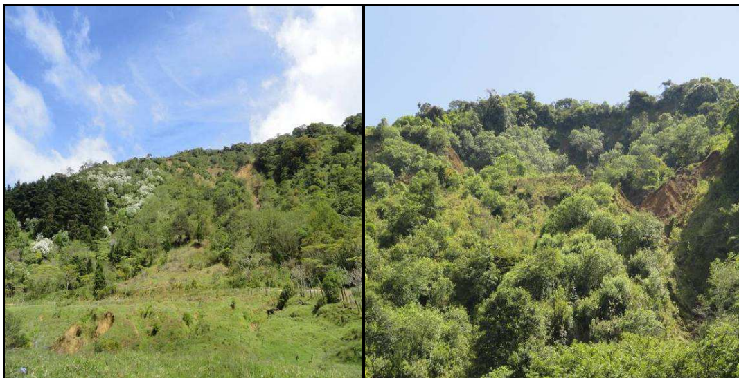
Fotografía Nº 6.1 y 6.2: Vista de la parte alta del deslizamiento, y en donde se deberían de efectuar los trabajos de abatimiento de la pendiente se puede observar el área es considerable y se debe tomar en cuenta que esta es solo una parte de toda el área que cubre el deslizamiento
