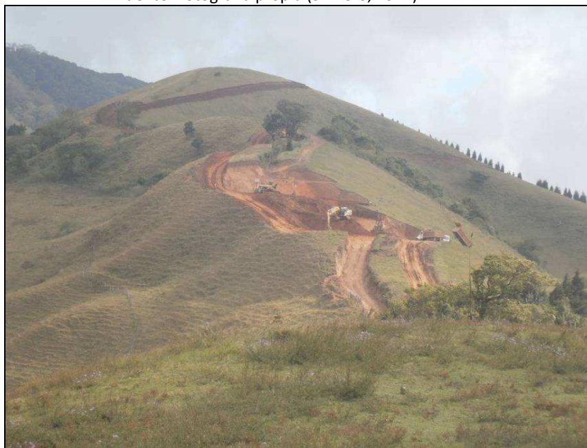
Fotografía N° 9.9: Proceso constructivo del Complejo de Generación de Energía Eólica de la CNFL. Fuente: Fotografía propia (9 Enero, 2012).
