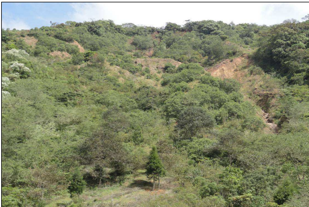
Fotografía 3.1: Vista del deslizamiento de Tapezco, en su parte superior.
