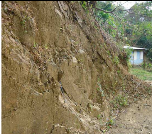
Fotografía Nº 2.1: Traza de la falla Uruca, fracturas abiertas verticales, se inclinan 88 al N25E. Camino a Matinilla, junto a Rio Uruca. 207800 N y 518050 W, Junto a Casa de Alcides, vista al NW.
