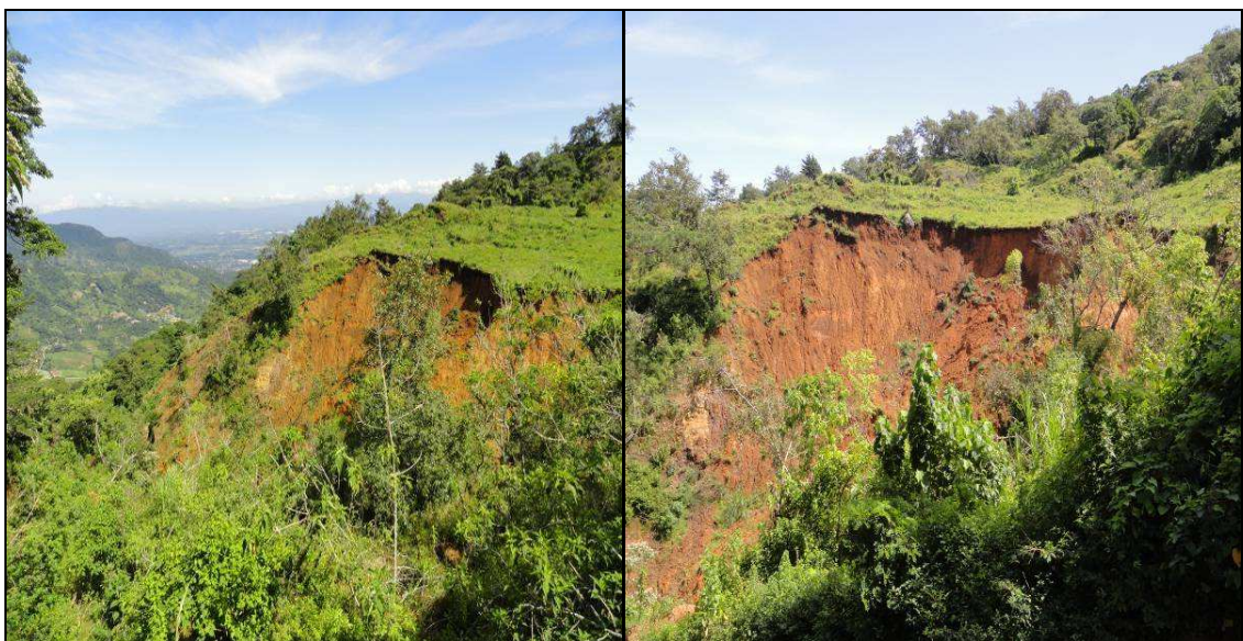
Fotografía N° 2.14 Y 2.15: Vista de las zonas de inestabilidad (erosión) sobre el bloque de la quebrada Pittier, se puede apreciar como se está presentando un retroceso de la pared de la margen izquierda aguas abajo.
