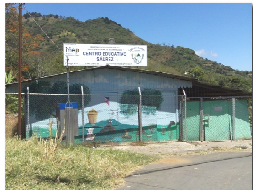
Fotografía N° 1.3. Vista parcial del centro educativo Sáurez
