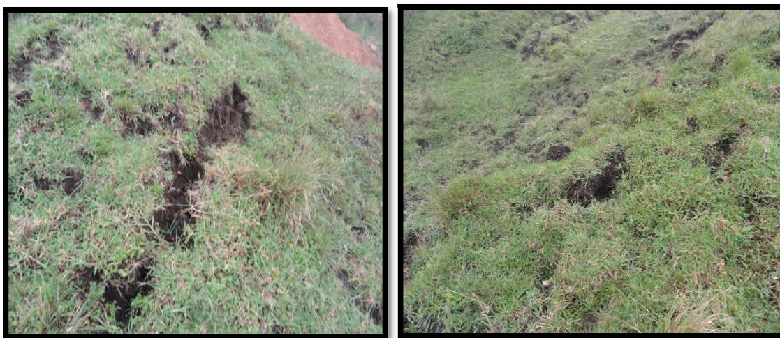
Fotografías Nº 5.5 y 5.6: En las fotografías se puede observar la existencia de grietas que se presentan en la zona alta del deslizamiento, obsérvese la topografía en donde se presentan las mismas.
