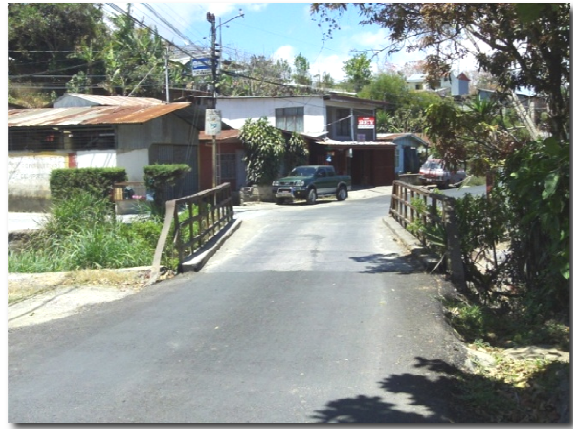
Fotografía N° 1.4. Puente para tránsito de vehículos en la parte baja.
