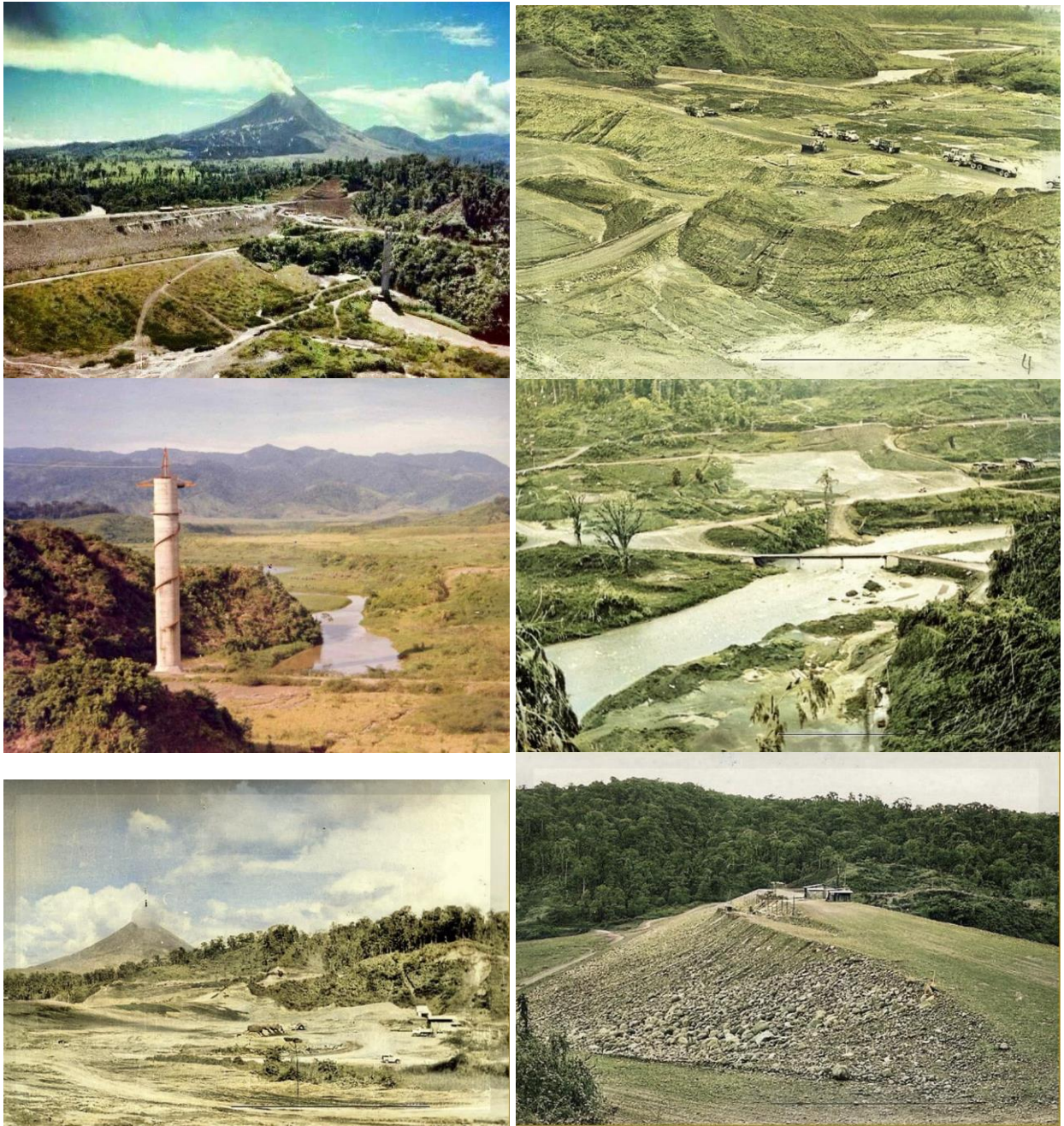
Fig. 1.12: Fotografías históricas de la construcción de la represa de Sangregado a finales de la década de 1970 (tres de ellas, pertenecen al Ing. Gastón Laporte; las otras son de fuente desconocida).
