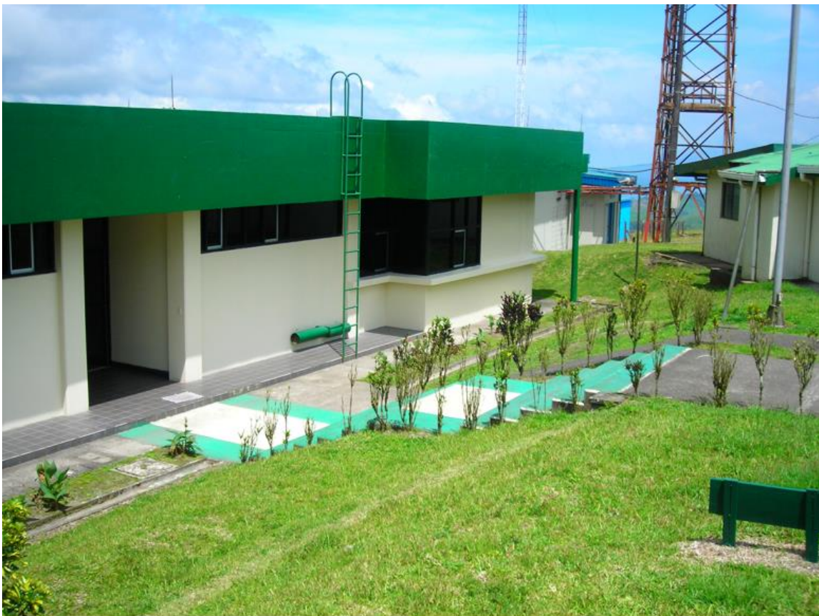
Fig. 7.12: Arriba la construcción del Observatorio Sismológico y Vulcanológico de Arenal y Miravalles (OSIVAM) en 1996 y abajo, una vez concluido. Cerro Chiripa, Tilarán.
