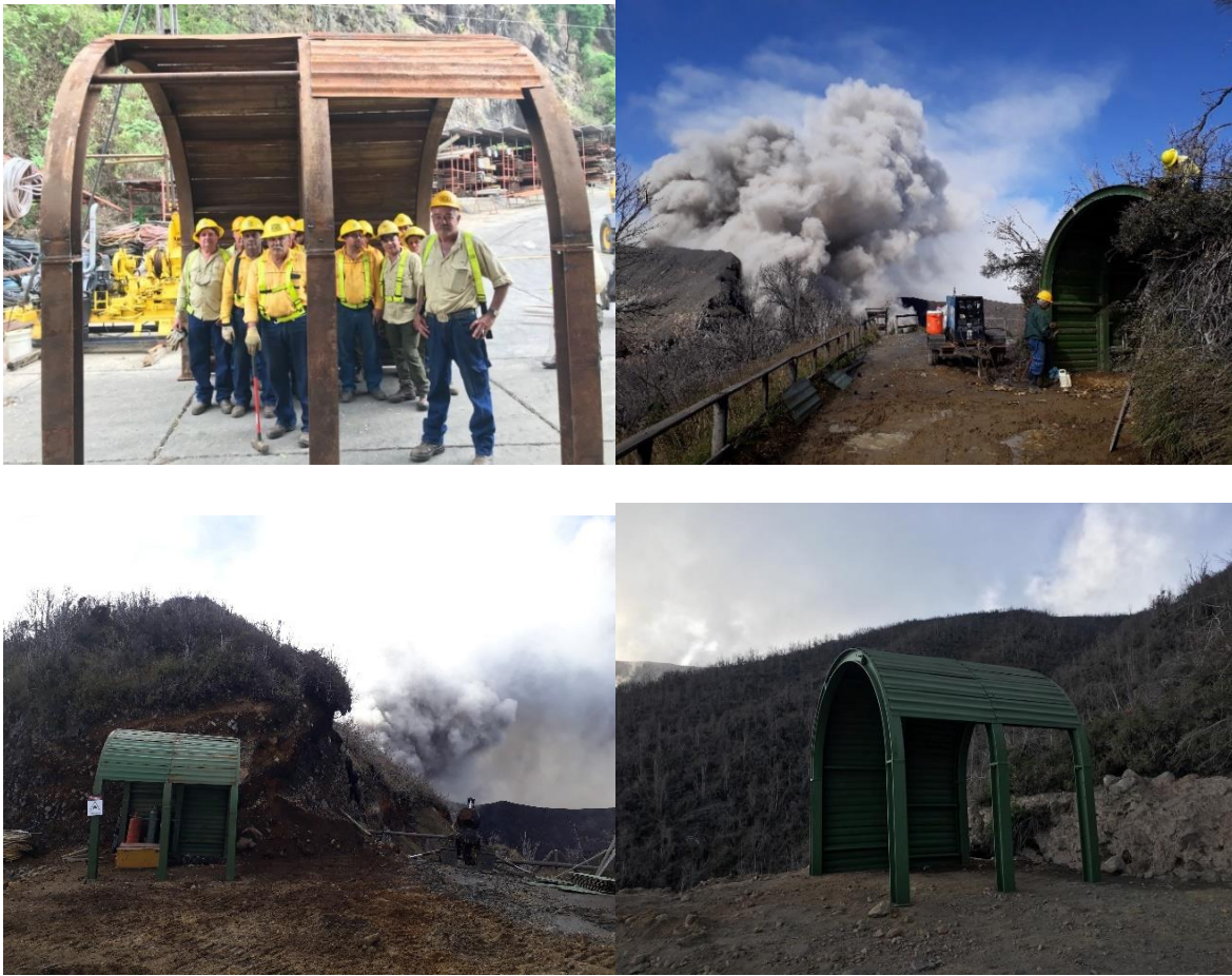
Fig. 4.18: Ejemplo de los siete refugios antibombas volcánicas, construidos en las instalaciones del ICE de la Garita, su proceso de instalación en el campo y acabados finales en el volcán Turrialba.
