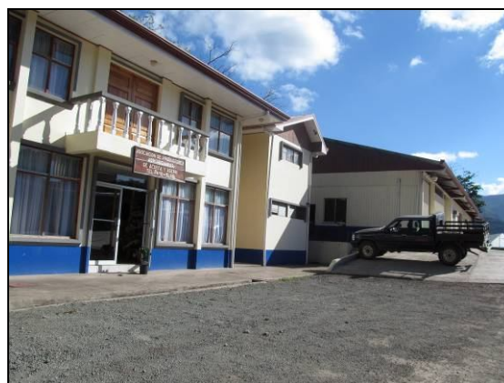
Fotografía 26: Edificio de oficinas que no evidencia ningún tipo de daño.
