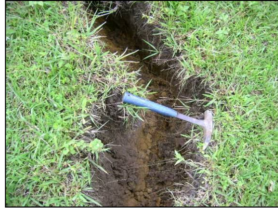
Fotografía 18: Grieta de tensión situada en la porción inferior de la zona afectada.
