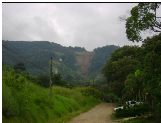
Fotografía 10: Panorámica desde calle Valverde con vista al deslizamiento Tablazo.
