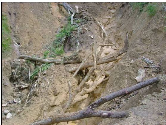
Fotografía 21: Troncos de árboles que obstaculizan en cauce natural.
