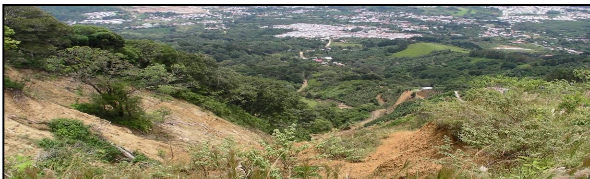
Fotografía 31: Panorámica del deslizamiento El Tablazo.
