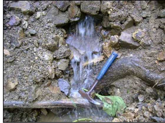
Fotografía 8: Afloramiento de agua subterránea ubicado en la ladera sur.
