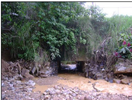
Fotografía 25: Puente alcantarilla que permite el acceso a la urbanización Los Pinos.
