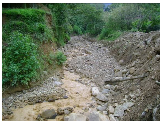
Fotografía 23: Canal de la quebrada Reyes que fue despejado y ampliado.
