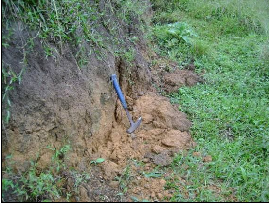
Fotografía 15: Escarpe y agrietamiento con desarrollo en etapas.
