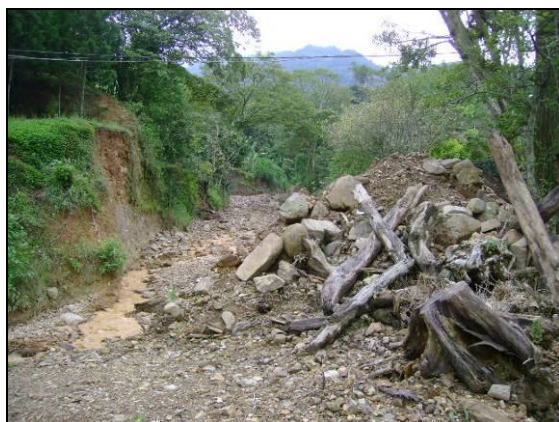
Fotografía 33: Dique sobre margen izquierda situado en Calle Valverde arriba.
