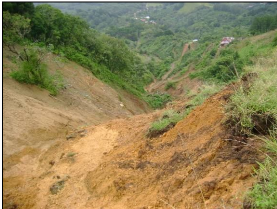
Fotografía 13: Cárcava vista desde la parte alta del deslizamiento.
