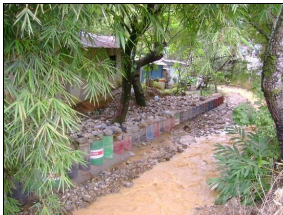
Fotografía 28: Viviendas sobre la margen izquierda aguas abajo del puente el Morado.
