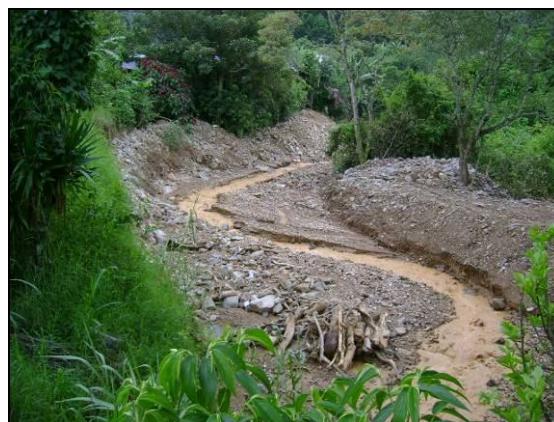
Fotografía 34: Canalización y construcción de diques aguas arriba del puente Los Pinos.
